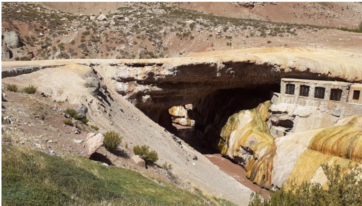
Puente del inca – foto PV - 2020
